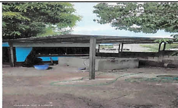
Contrucción de Galera para la pila.
