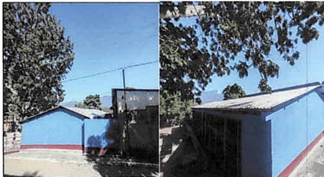
pintura en muros interiores y exteriores.
