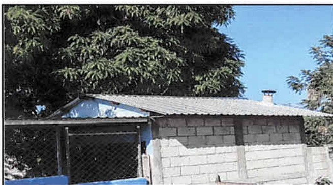
Sustitución de malla en muro perimetral.
