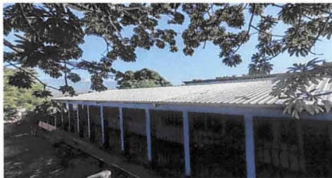
Sustitución de Lámina
